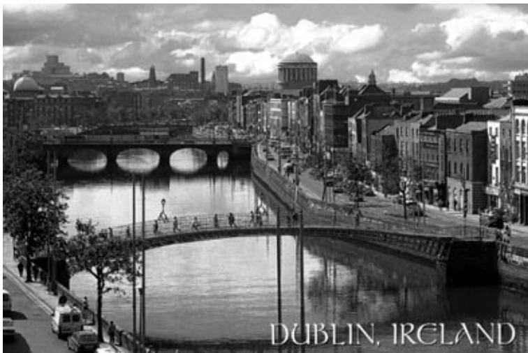
A Ha'penny Bridge a Liffey fölött (a háttérben jobbra a Four Courts)
